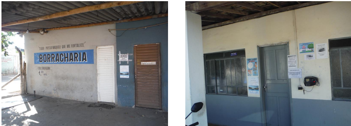
Figura 6.5 – Cartaz de divulgação afixado em locais públicos da região de abrangência do Projeto, Município de Prudente de Morais.
