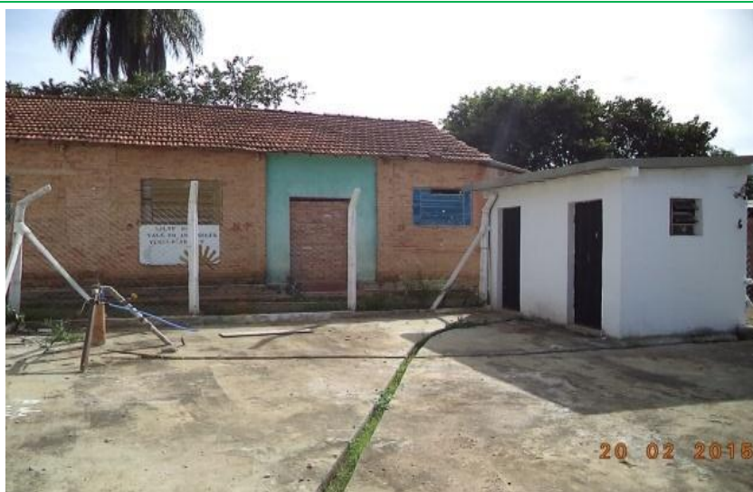
Figura 3.11 – Poço Creche em Campo de Santana.
