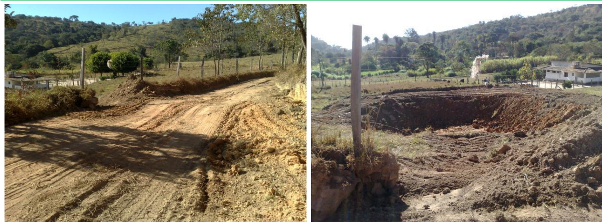
Figura 3.18 – Obra de drenagem pluvial na estrada de Matos
