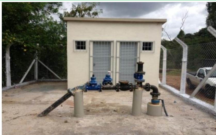
Figura 3.10 – Poço C01 em Campo de Santana
